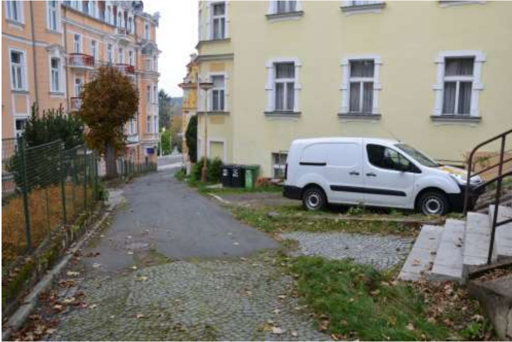
Obr. 6. – Nesprávné použití několika materiálů na jednom místě v centrální části Mariánských Lázní
