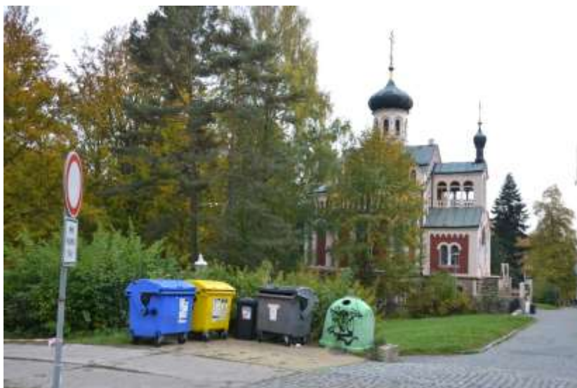
Obr. 7. – Nevhodné umístění odpadních nádob v blízkosti kulturní památky
