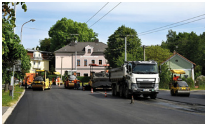
Na snímku je oprava Palackého ulice v místech U Kovárny.
