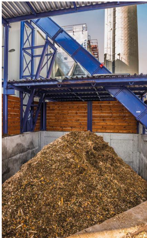
Obrázek 25: Zásobník paliva pro kotel K7
