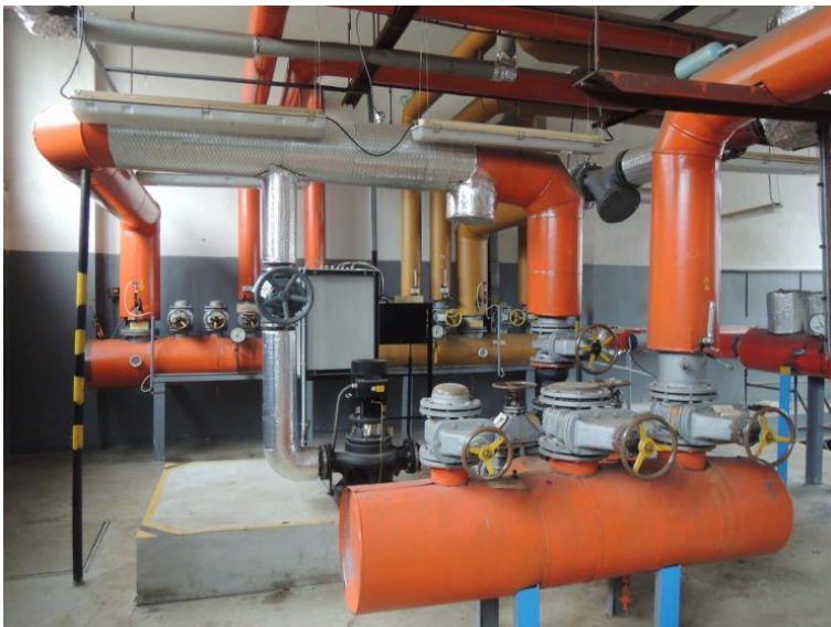
Obrázek 29: VS 99 Tuzex před rekonstrukcí
