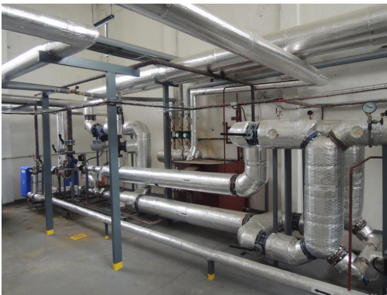
Obrázek 30: VS 78 Česká po rekonstrukci v roce 2014
